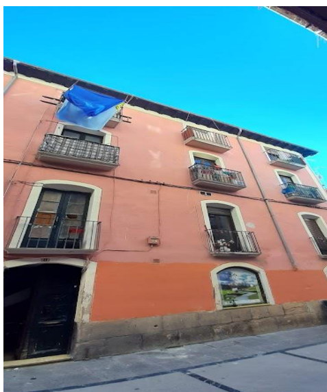
Ilustración 35: Edificio en calle La Estrella
